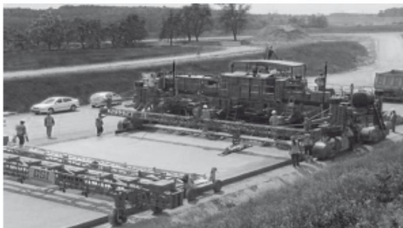
14.1 – сурет – Жылжымалы формалы бетонды төсегіштермен жабынды салу
